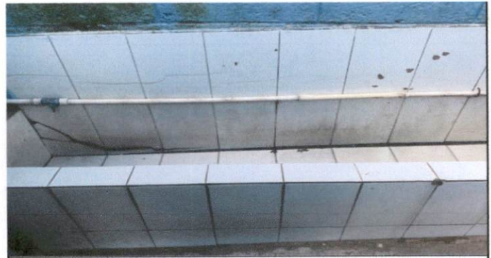
Foto 6: Sustrucción de mingitorio
