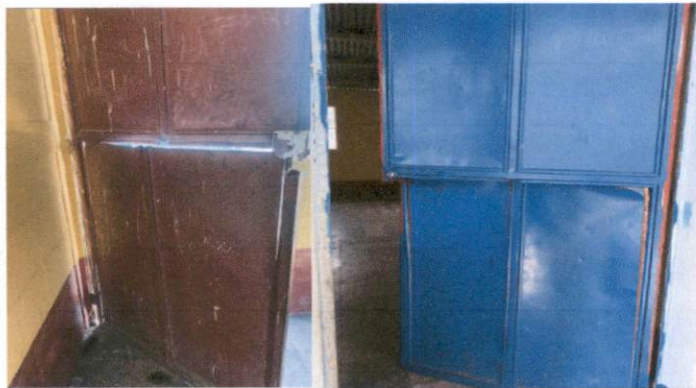
Foto 3: Mantenimiento a estructura (lijado, cambio de tubo , cepillado, sujeciones, aplicación de pintura)
